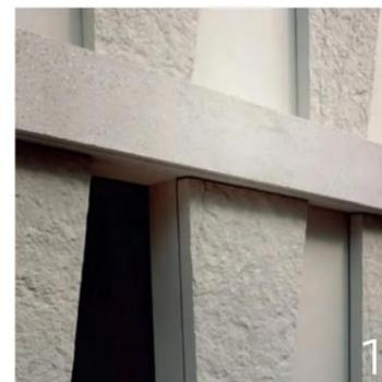
**1. Haptisch:** Glatt, gestockt und strukturiert – das Zusammenspiel von drei unterschiedlichen Betonoberflächen wirkt im Detail besonders effektiv.
